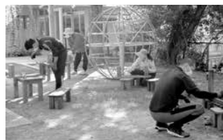
遊具への防腐剤塗り
